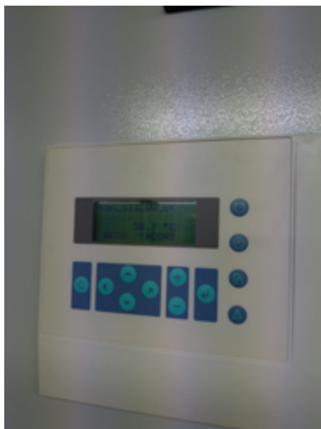
Fig. 3 – centralina di controllo parametri impianto e programmazione cicli shock termico
