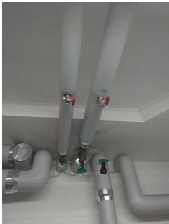
Fig. 1 – condotti di mandata e ricircolo acqua calda sanitaria, con le prese utilizzate per il prelievo dei campioni
