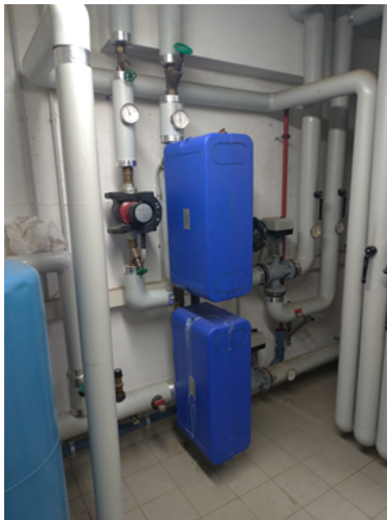
Fig. 2 – scambiatori di calore
